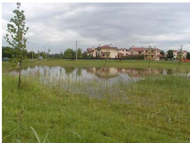
**Figura 5.3 - Volume di invaso ricavato tramite depressioni in aree verdi, in periodo secco (a sinistra) e durante una piena (a destra)**
